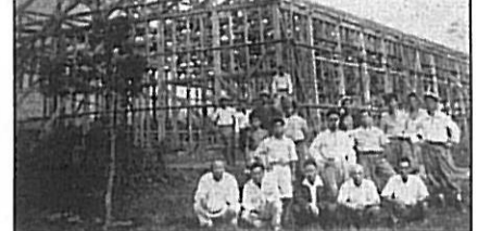
第一期工事開始 S.12.3 (1937)
