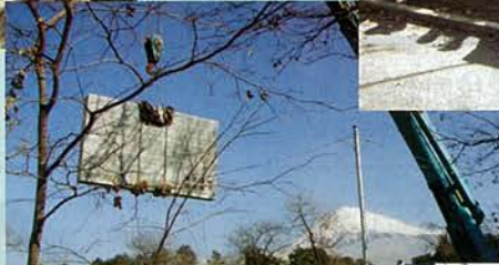
▶台座への取付け作業
